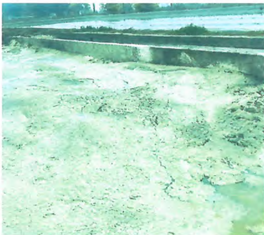
Imagen 2: Cancha de secado de lodos
