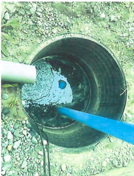
Imagen 1: Colector de percolados de la cancha de secado.
