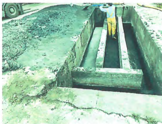
Imagen 4: Limpieza pozo decantador
